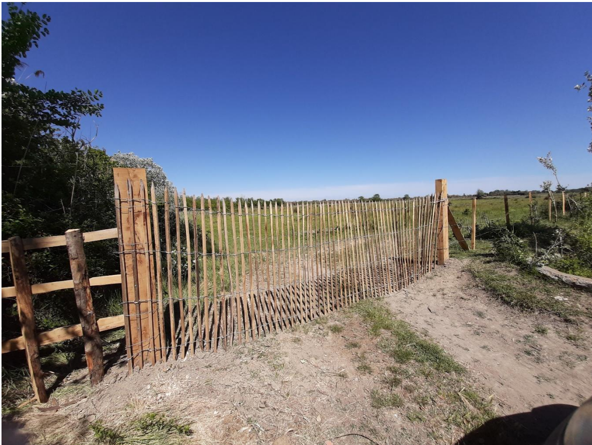
Photo 25 : Prise de vue de la clôture installé après chantier (P. Rocarpin, Tour du Valat, 2023)
