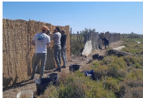
Figure 22 – Chantier à l'observatoire du Saint-Seren © M. Lourenço / RNR TdV
