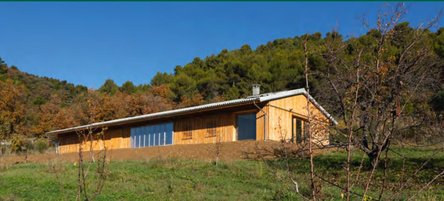
Un bâtiment unique avec une architecture vernaculaire agricole en bois issu du massif alpin qui s'adapte et se transforme selon le programme. Il peut être très ouvert et ventilé pour le stockage du matériel et des engins, plus opaque mais ventilé pour le stockage des produits, opaque pour la chambre froide, translucide pour l'atelier et le garage, opaque avec cadrages sur le paysage pour la partie vestiaire, couchages et cantine.
