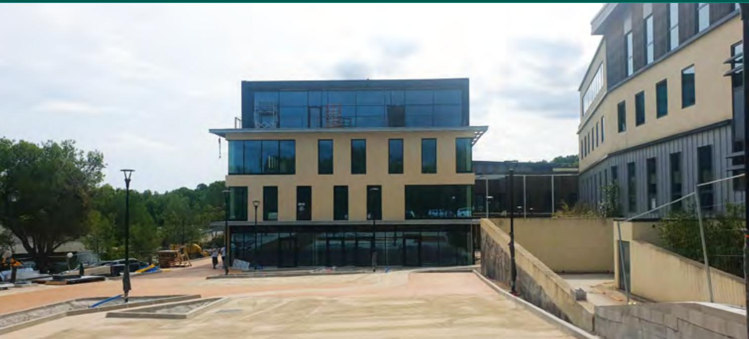
Bâtiment tertiaire sur quatre niveaux à usage de bureaux. Le dernier niveau en attique avec son bardage bois vertical à claire-voie en douglas pré-grisé offre des lieux de travail très agréables. Les niveaux intermédiaires en ossature bois enduits et le rez-de-chaussée en béton est tantôt vitré ou revêtu d'un bardage métallique. Cette mixité permet l'utilisation optimale des matériaux selon leurs performances.
