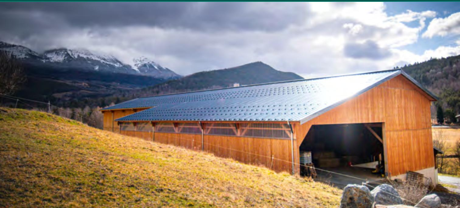
Bâtiment multifonctionnel et connecté à son époque. Afin de produire du lait fromageable, sans ensilage, le GAEC du Buissonnet a décidé de construire une extension bois pour stocker et sécher son foin en vrac grâce à la chaleur naturelle récupérée sous la toiture. Si la grange constitue la partie principale du bâtiment, on trouve aussi deux appentis dont un équipé pour accueillir les génisses.
