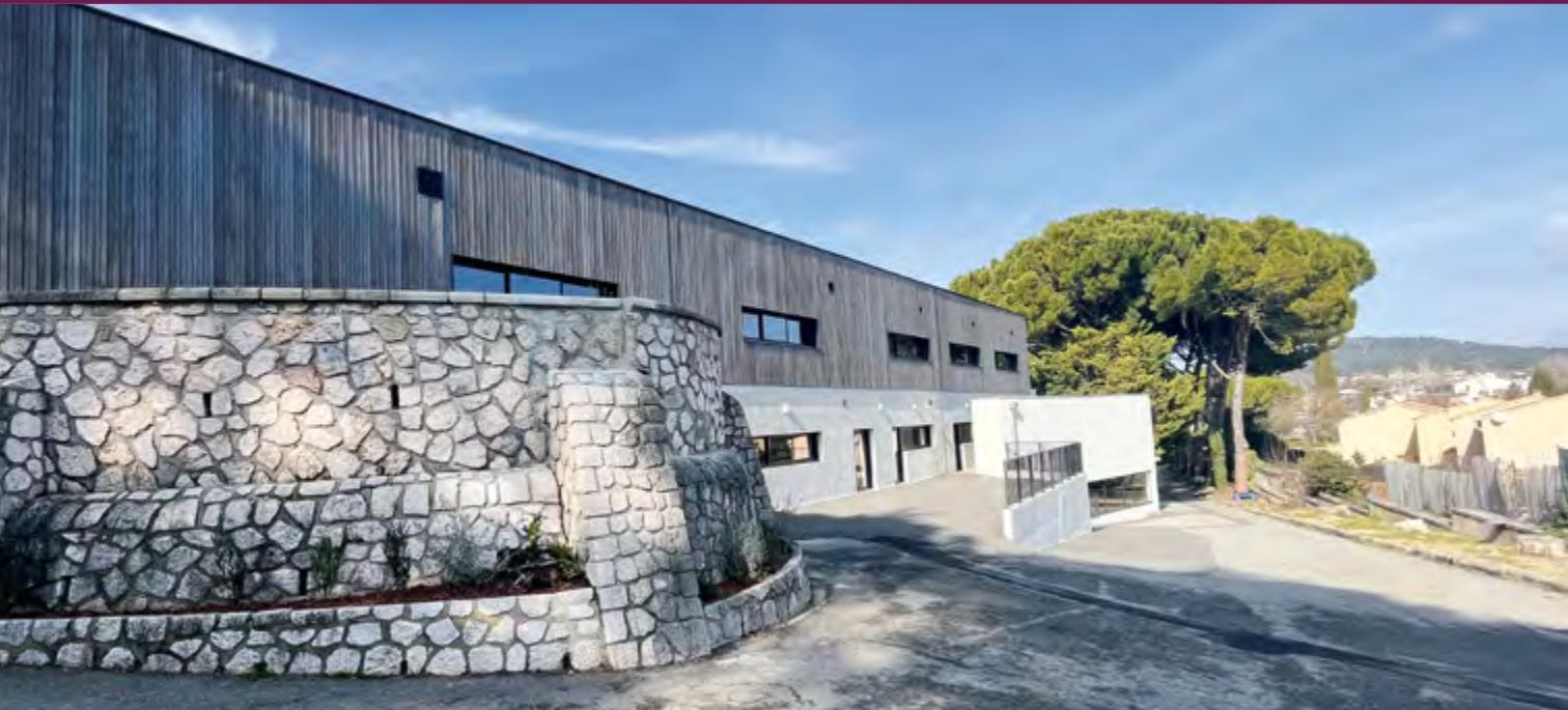
Une construction mixte bois et béton assurant une parfaite étanchéité, une performance thermique au bâtiment et une bonne inertie apportée par le béton. En termes de façade, un jeu de couleurs et de matériaux permet de différencier chaque niveau et de rompre la monotonie.
