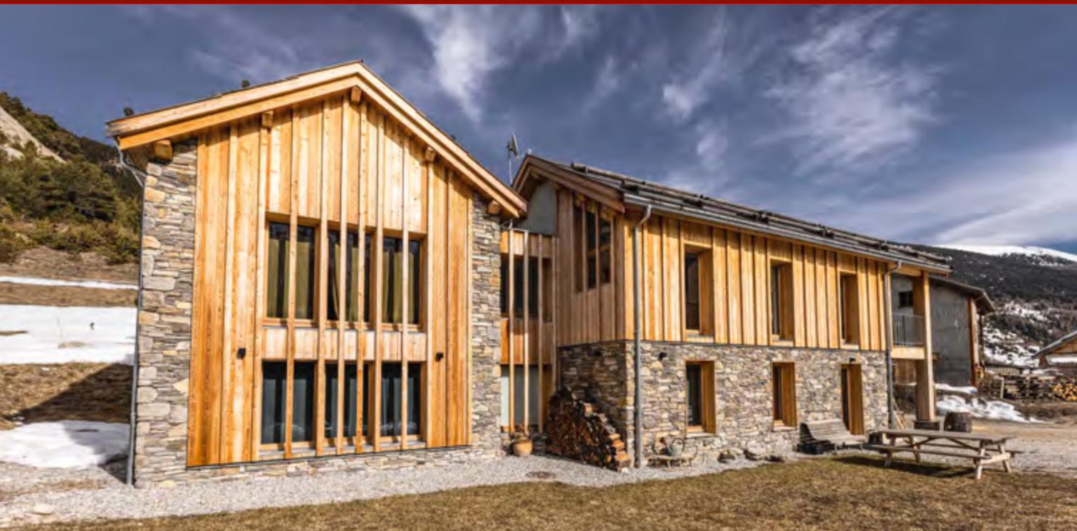
Cette construction traditionnelle se compose d'un volume principal en R+1 allongé dans le sens des courbes de niveaux, accompagné d'un volume annexe en R+1 perpendiculaire et en retrait de l'alignement de la façade Sud. La façade Est faite de madriers et planches de mélèze en pose verticale, avec une couverture en bardeaux de mélèze naturel. Les menuiseries sont en mélèze de couleur naturelle. Le tout crée une allure rustique et chaleureuse.
