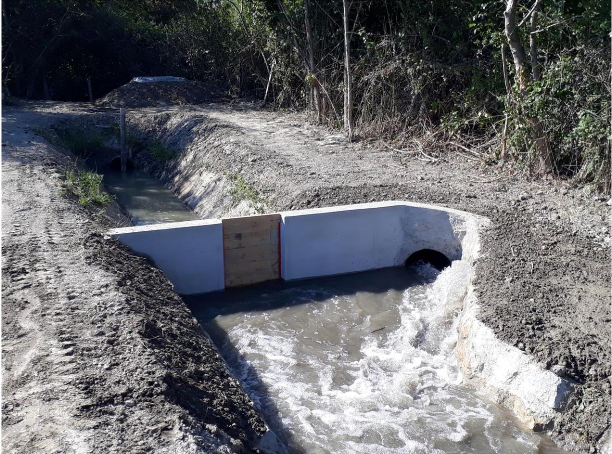
Figure 25 : Nouvelle arrivée d'eau et seuil à planches réalisées en 2022
