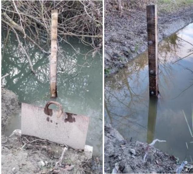
**Figure 13. Echelles de niveau de part et d'autre de la nouvelle martellière permettant une arrivée gravitaire (sur le canal du Japon (gauche) et dans le canal d'amenée d'eau au marais (droite))**
