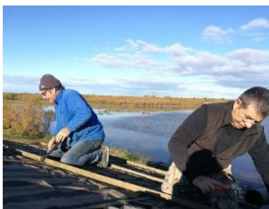
Réfection du toit de l'observatoire
