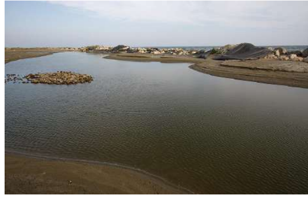
Affaissements de digues au droit des Sablons, vu depuis la propriété du Conservatoire du Littoral . Photo : M. Thibault, juillet 2010.
