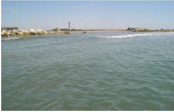
Grande brèche au droit des Sablons, vue depuis la mer. Photo : L. Willm, juillet 2010.
