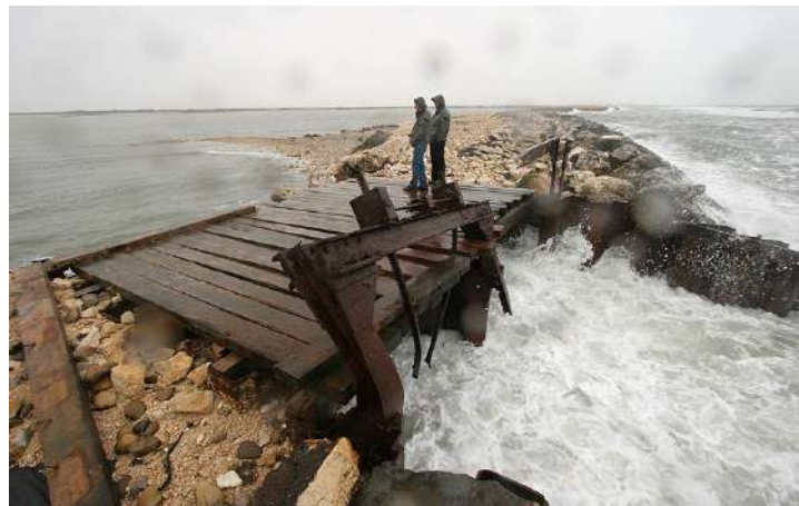
Entrée marine dans l'étang de Beauduc par l'ancienne martelière de Véran. Photo : M. Thibault, mars 2011.
