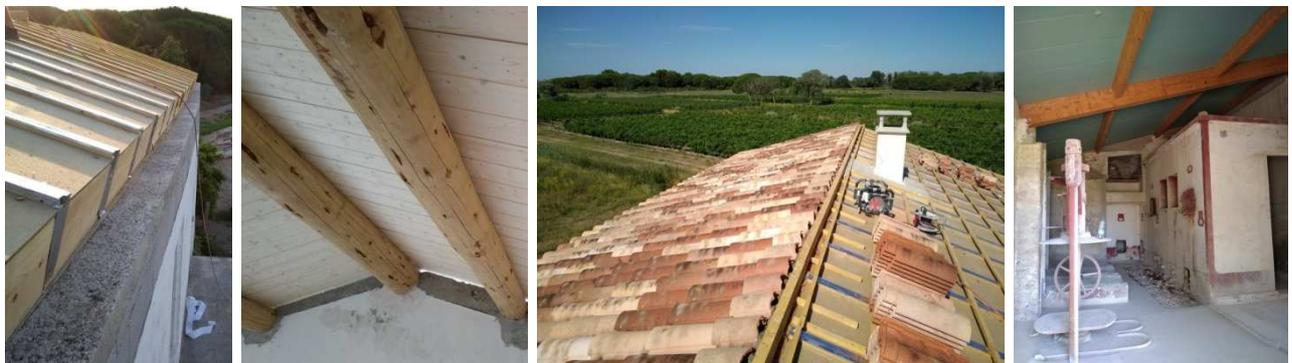
**De gauche à droite : Détail des caissons isolés avec de la fibre de bois, finition sous toiture intérieure, pose des tuiles et vue de la prochaine zone de vente qui sera aménagée dans l'ancien chai.**
