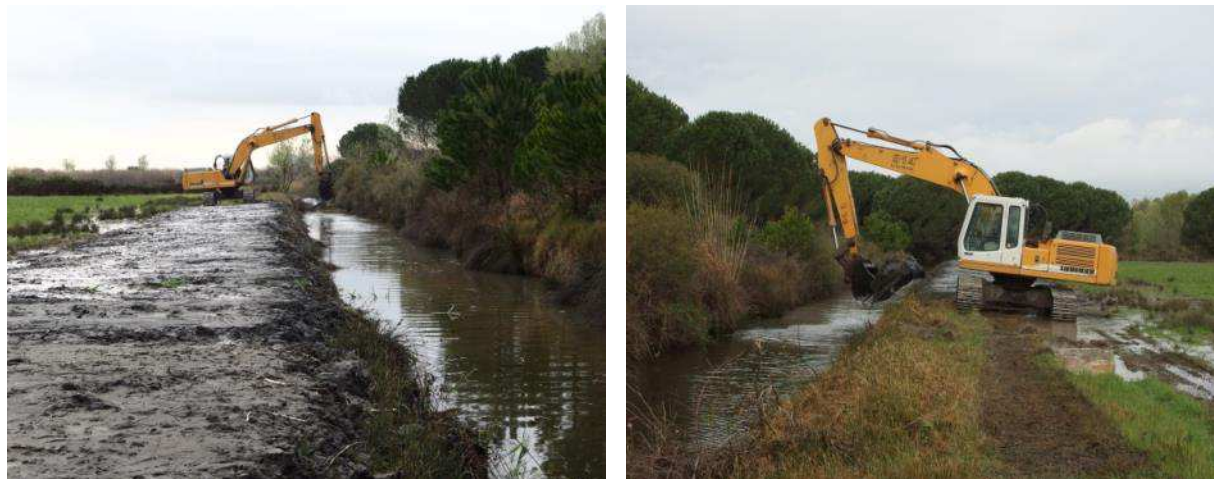
Travaux de curage des canaux en avril 2018
