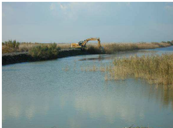
Creusement des pesquiers dans l'étang Nord
