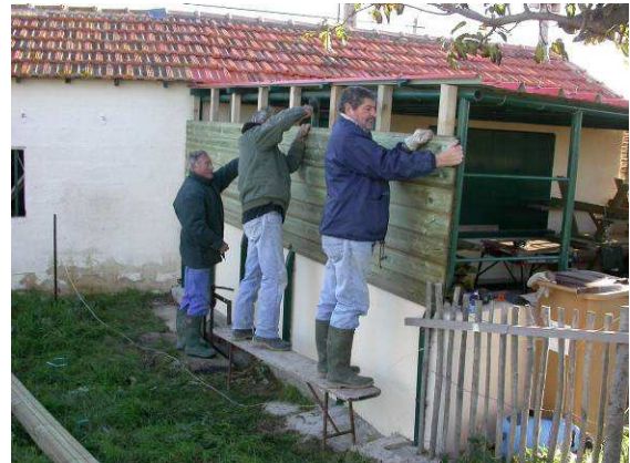
Réfection du cabanon.
