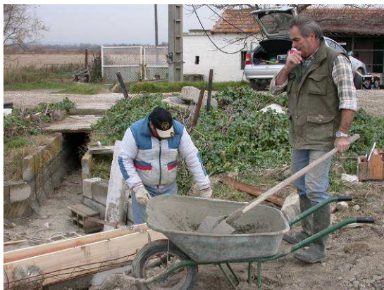
Mise en état du cuvón.
