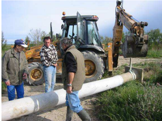
Mise en place d'une buse équipée d'une martelière.
