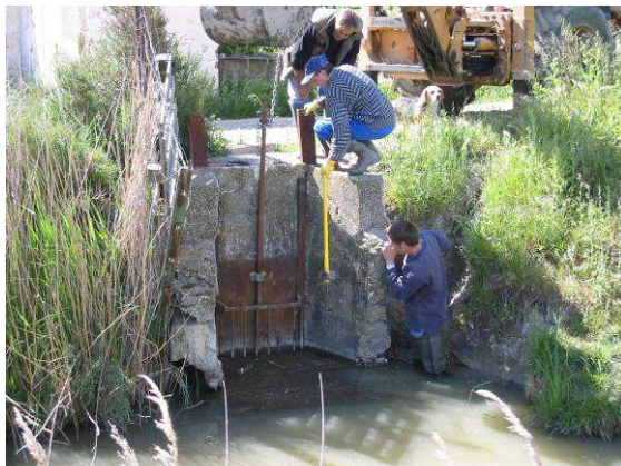
Remplacement d'une martelière.
