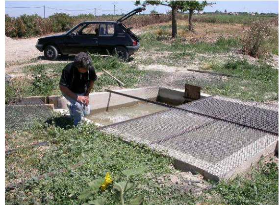
Sécurisation du cuvón par des grilles.
