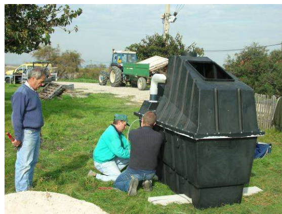
Installation des toilettes sèches.
