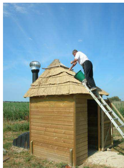
Finalisation de la toiture des toilettes sèches.
