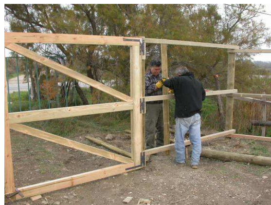
Remplacement de tous les portails par des structures en bois.
