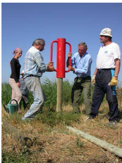
Mise en place d'une clôture.
