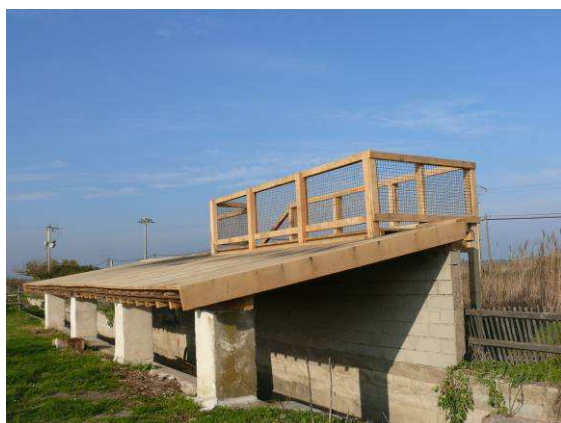
Aménagement d'une plate forme sur le toit du hangar
