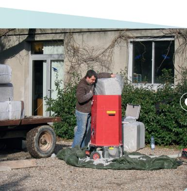
Insufflation de ouate de cellulose dans les combles des bureaux
