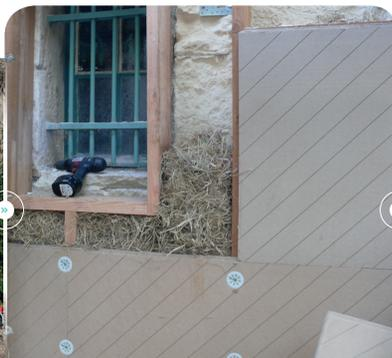
Détail de l'isolation à la paille de riz (Pré-cadre de la fenêtre et support du coffrage en bois, coffrage en fibre de bois compressé et remplissage manuel avec de la paille en vrac)
