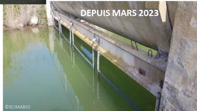
Figure A74 : Reconfiguration des antennes de la station d'écoute RFID « Fume-Aval » au canal du Fumemorte par Scimabio Interface en Mars 2023
