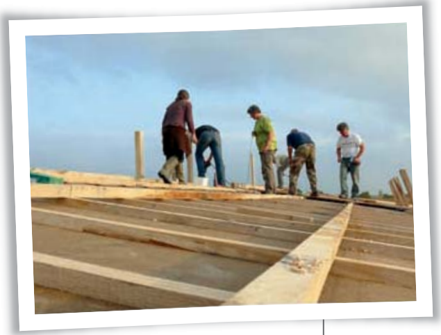
Chantier participatif pour le remplacement de la toiture du hangar.
