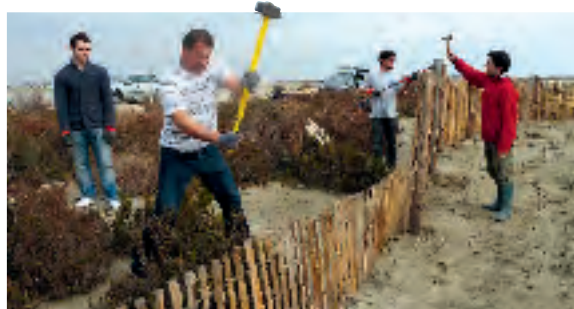
○ Pose de ganivelles sur le Fangassier dans le cadre d'un chantier Accor
