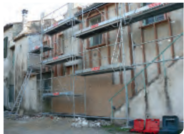
Mise en place du coffrage d'isolation
