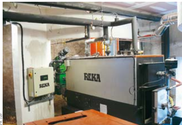
Nouvelle chaudière à biomasse installée à l'automne 2009
