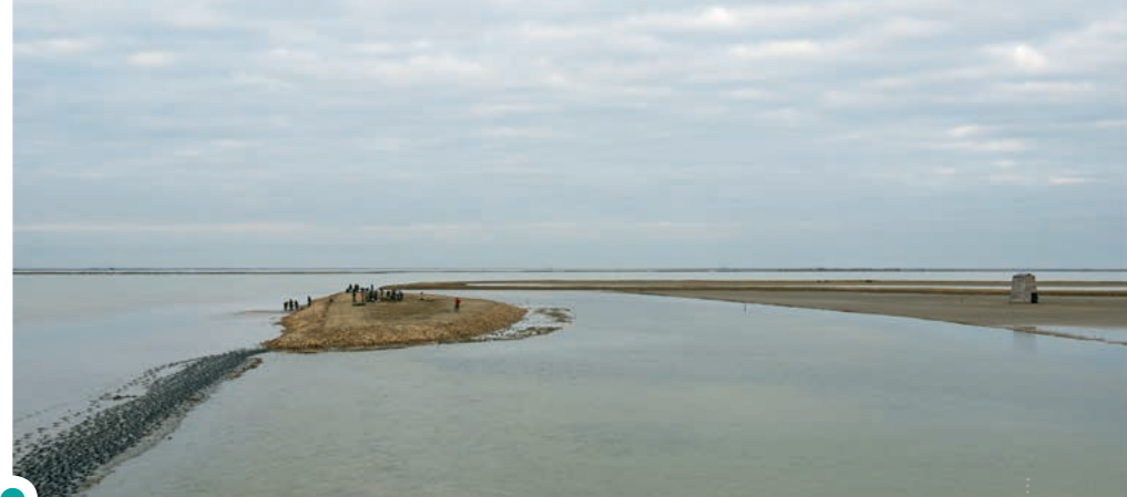
Un nouvel îlot d'une superficie de 5 000 m 2 a été construit durant l'hiver 2015-2016 en effaçant 100 m de digue de part et d'autre de la digue séparant les Fangassier I et II. L'ancien îlot est relié à la digue centrale afin de le rendre moins attractif pour les flamants.
